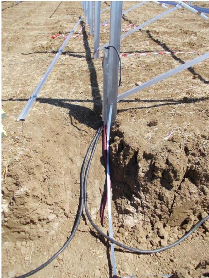
Ejemplo de pletina conectada a poste de estructura
