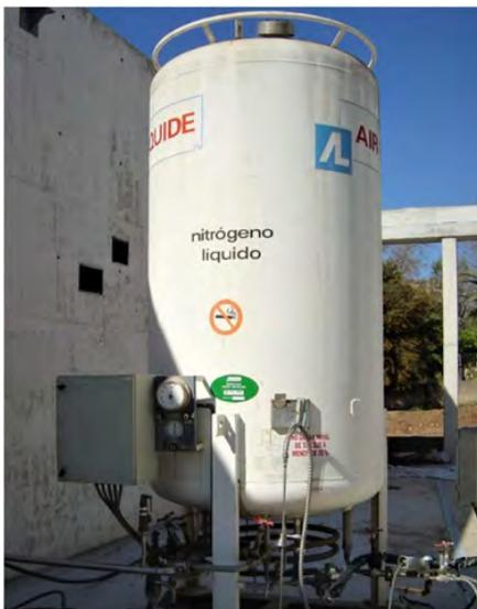
Ejemplo de tanque de nitrógeno líquido.
